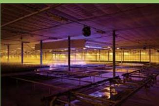
既存のナトリウムランプ補光照明の1/2の消費電力で代替可能
